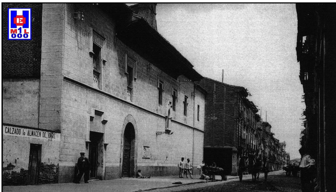
Foto 2 Hospital de Antezana en Alcalá de Henares
